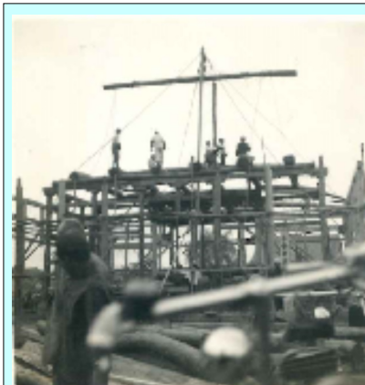
仮柱に滑車を付け吊り上げ
